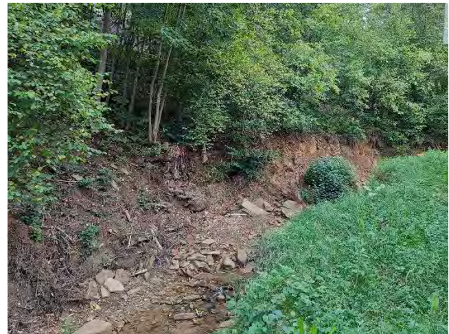
Profil 8 nach Hochwasserereignis
