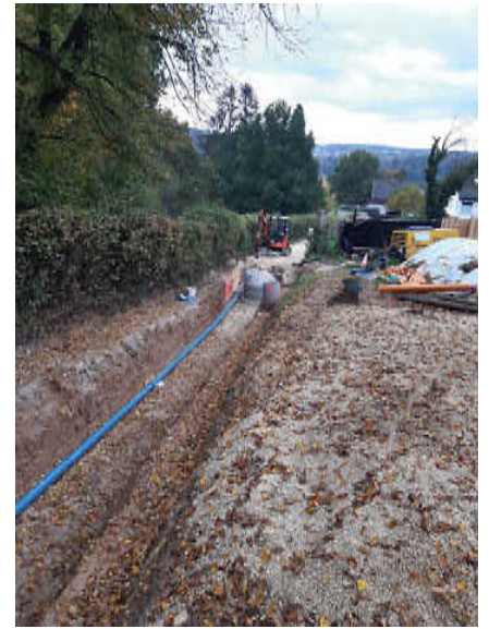
Neue Wasserleitungen wurden im Fußweg neben dem Freibad verlegt.
