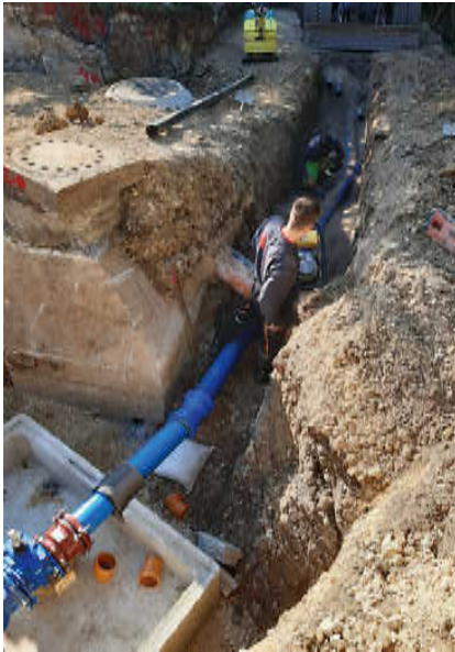
Arbeiten am neuen Schacht und den Wasserleitungen in der oberen Martinstraße.
