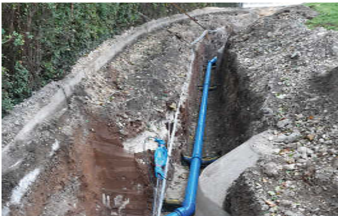
Neben neuer Wasserleitungen wurden auch die Stromkabel erneuert.
