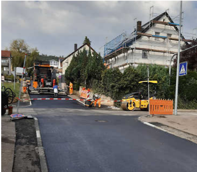
Den Anwohnerinnen und Anwohnern steht für die kommenden Jahrzehnte eine komplett erneuerte Infrastruktur zur Verfügung.
