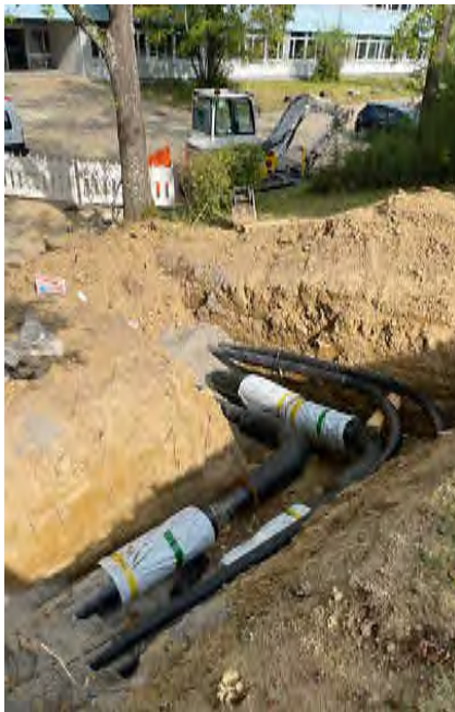
Am Raichberg-Schulzentrum wurde die Nahwärmeleitung zwischen den Gebäuden erneuert.
