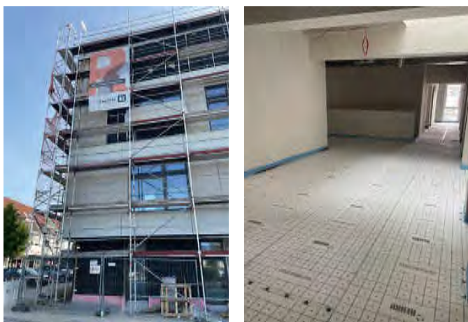
An der Baustelle des Kinderhaus Stadtmitte II ging es unter anderem mit den Fassadenbauarbeiten weiter und es wurde mit dem Einbau der Fußbodenheizung begonnen.
