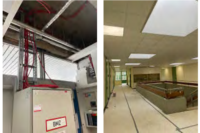
Der erste Teil der Brandmeldeanlage wurde erneuert und in diesem Zusammenhang auch die abgehängten Decken, deren Beleuchtung auf LED umgestellt wurde.
