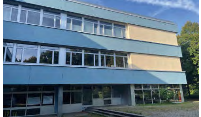
Die Fassade des Hauptgebäudes am Raichberg-Schulzentrum wurde gründlich gereinigt.
