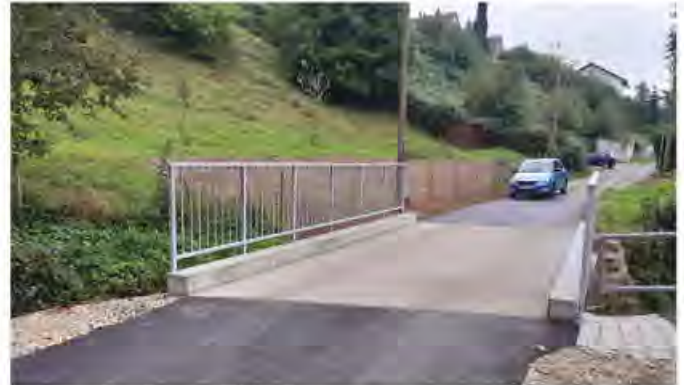
Die Brücke wurde inzwischen für den Verkehr freigegeben.
