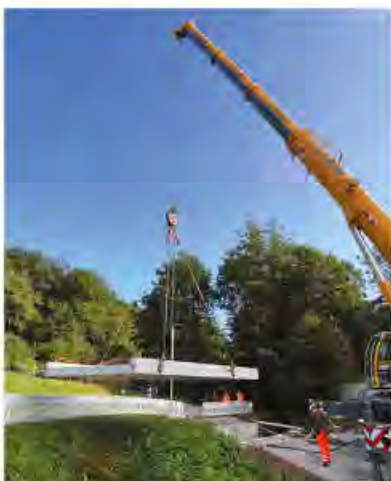
Anlieferung der neuen Brücke im Bachtal mit einem Autokran Ende August.
