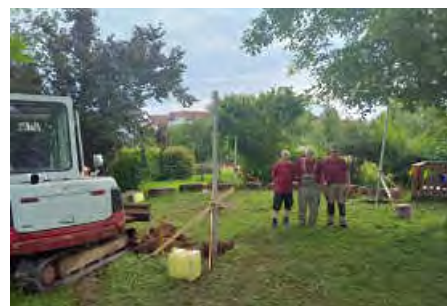
Ein Großer Dank geht an den städtischen Baubetriebshof. So konnte das Sonnensegel noch vor den Sommerferien installiert werden.
