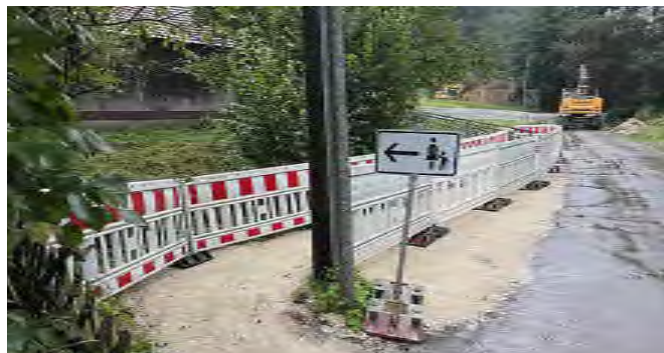
Fußgänger kommen auch während der Bauphase ins Bachtal.
