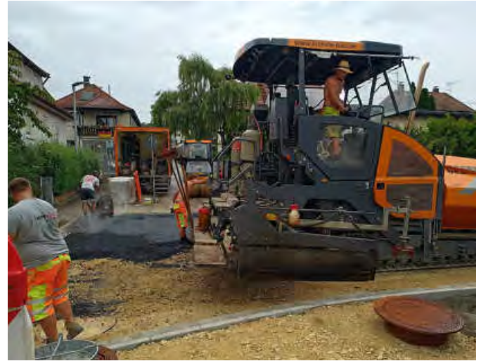
Am vergangenen Freitag erfolgte der Einbau der ersten Asphaltschicht in der Gartenstraße.
