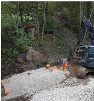
An der Böschung werden zur Sicherung des Bachbettes und der Böschung entsprechende Sicherungsmaßnahmen durchgeführt.
